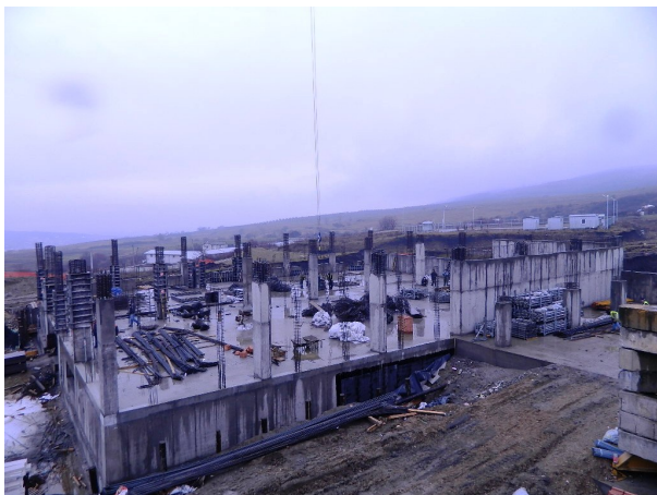
Stadiul lucrĂfrilor - final 2013
