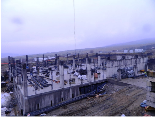
Stadiul lucrĂfrilor - final 2013
