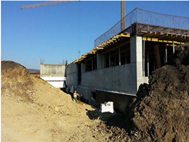
Stadiul lucrĂfrilor - martie 2014
