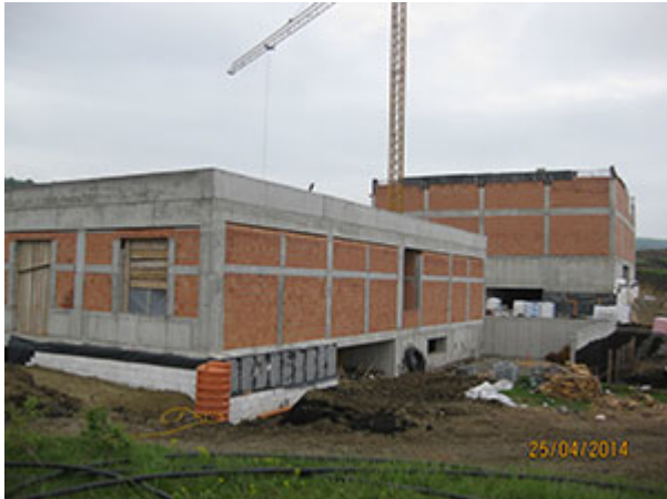
Stadiul lucrĂfrilor - aprilie 2014
