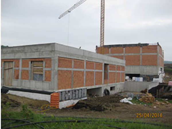
Stadiul lucrĂfrilor - aprilie 2014
