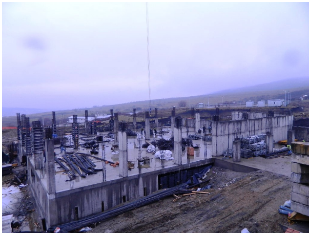
Stadiul lucrĂfrilor - final 2013
