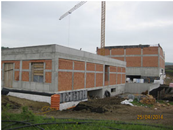
Stadiul lucrĂfrilor - aprilie 2014
