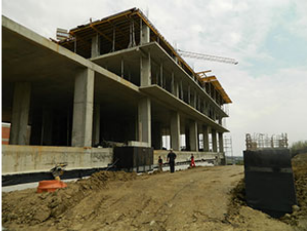
Stadiul lucrĂfrilor - iulie 2014
